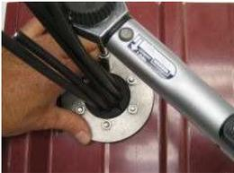
Die TDD mit etwas Druck auf das Trapezblech pressen, gleichzeitig die Muttern kreuzweise in mehreren Schritten mit 5 Nm (empfohlenes Anzugs-Drehmoment) anziehen.
