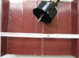
Anzeichnen der gewünschten Durchführungsposition zwischen 2 Stegen (hohe Stellen des Trapezblechs) in der Mitte der Sicke (tiefe Stelle des Trapezblechs), bohren der Durchführungsöffnung mit Hilfe einer Zylindersäge, entgraten der Bohrung.
