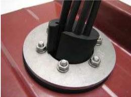
Kabel in den geteilten Wechseleinsatz einlegen, Wechseleinsatz in die TDD einsetzen. Darauf achten, dass der Wechseleinsatz so weit in die TDD eingeschoben wird, bis dieser oben mit dem Gummi der TDD bündig ist. Nicht benötigte Öffnungen im Wechseleinsatz mit beiliegenden Gummistopfen verschließen.
