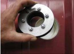
Einsetzen der Trapezblechdachdurchführung (TDD) (ohne Wechseleinsatz) in die Durchführungsöffnung, alle Kabel durch die TDD führen.
